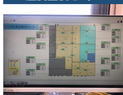
温度監視モニター
