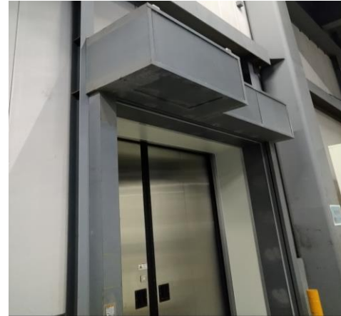
1階 倉庫内に自動扉2つ
